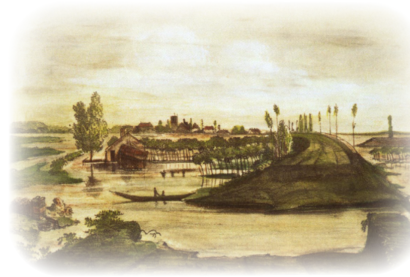
Brèche de la levée de Saint-Pryvé après la crue de 1856
