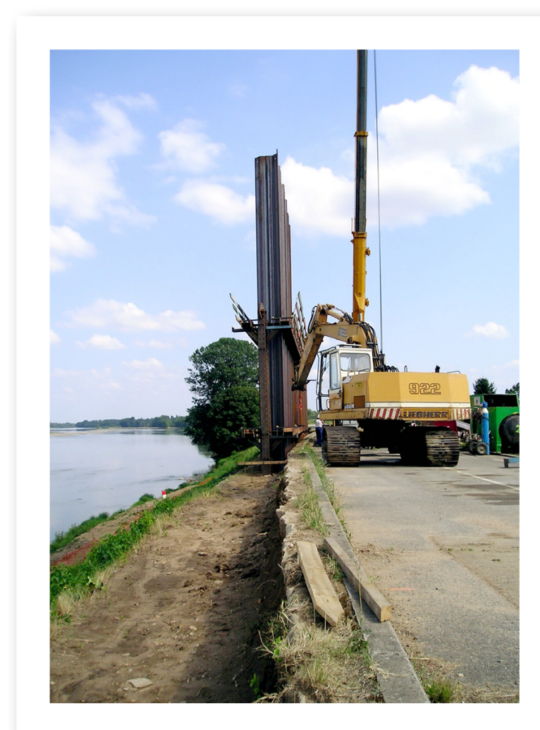
Pose de palplanches à Saint-Benoît-sur-Loire
